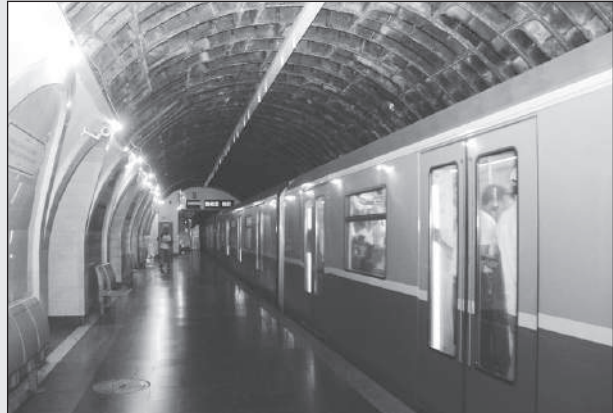
"Bakı Metropoliteni"nin "Nizami" stansiyasında aparılan təmir işləri davam etdirilir.
